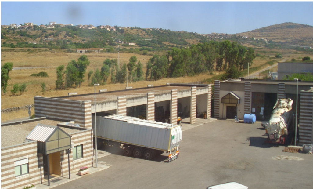
Figura 18 Edificio Autorimessa – stato attuale
