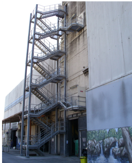
Figura 29 La scala esterna in acciaio da smontare e rimontare
