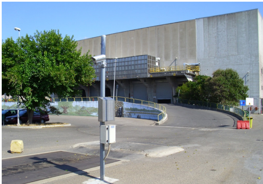
Figura 32 Area di ingresso all'attuale Edificio Fossa con il piazzale per il conferimento
