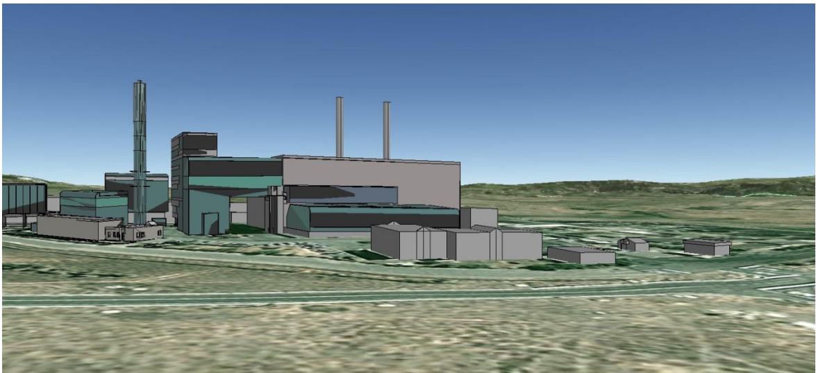
Figura 8 Simulazione fotografica di dettaglio dell'Impianto di progetto nella piana dell'area industriale Tossilo (base fotografica Google Earth)
