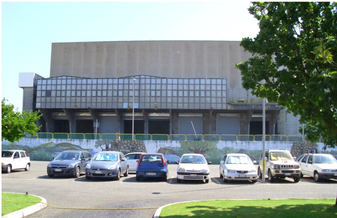
Figura 26 Edificio Fossa – stato attuale
