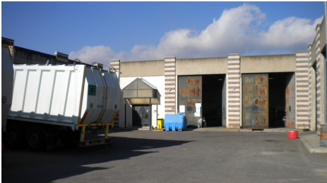
Figura 22 Edificio Officina – stato attuale
