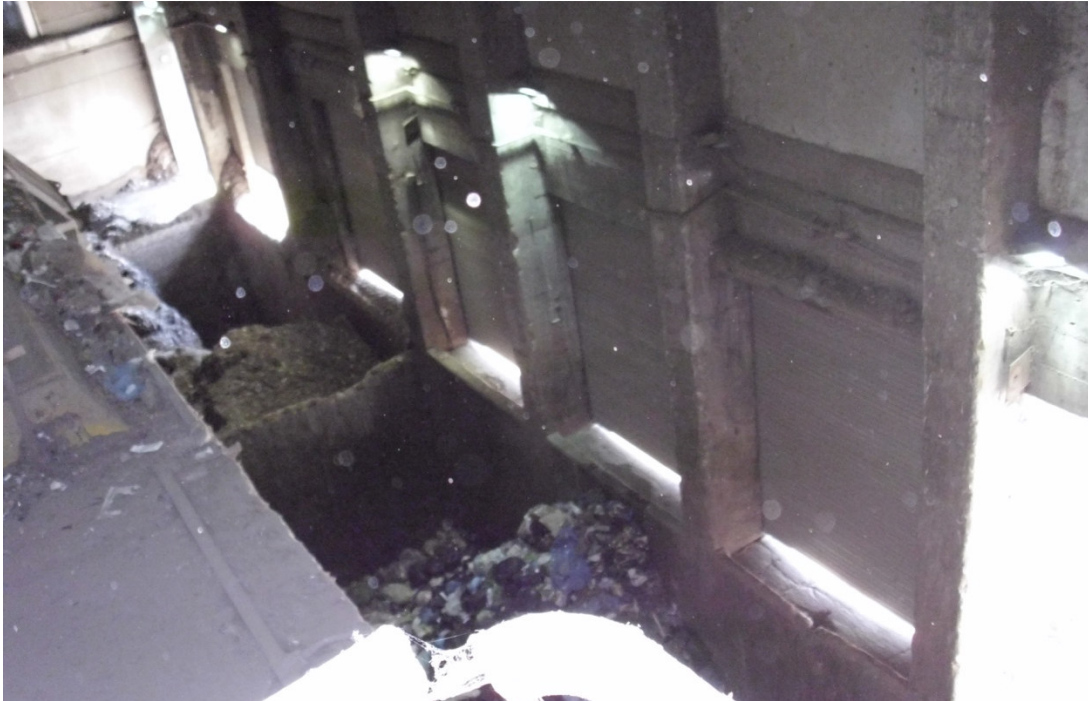
Figura 27 Edificio Fossa: la vasca di raccolta dei rifiuti – stato attuale
