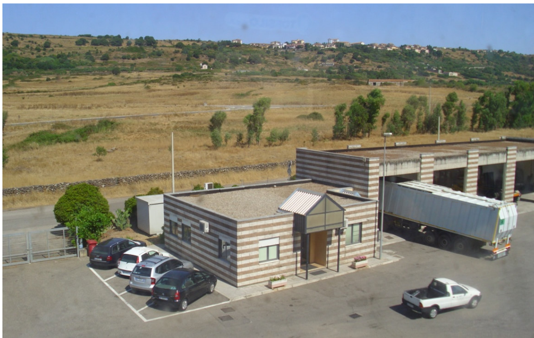
Figura 16 Vista dell'Edificio Servizi e dell'Autorimessa– stato attuale
