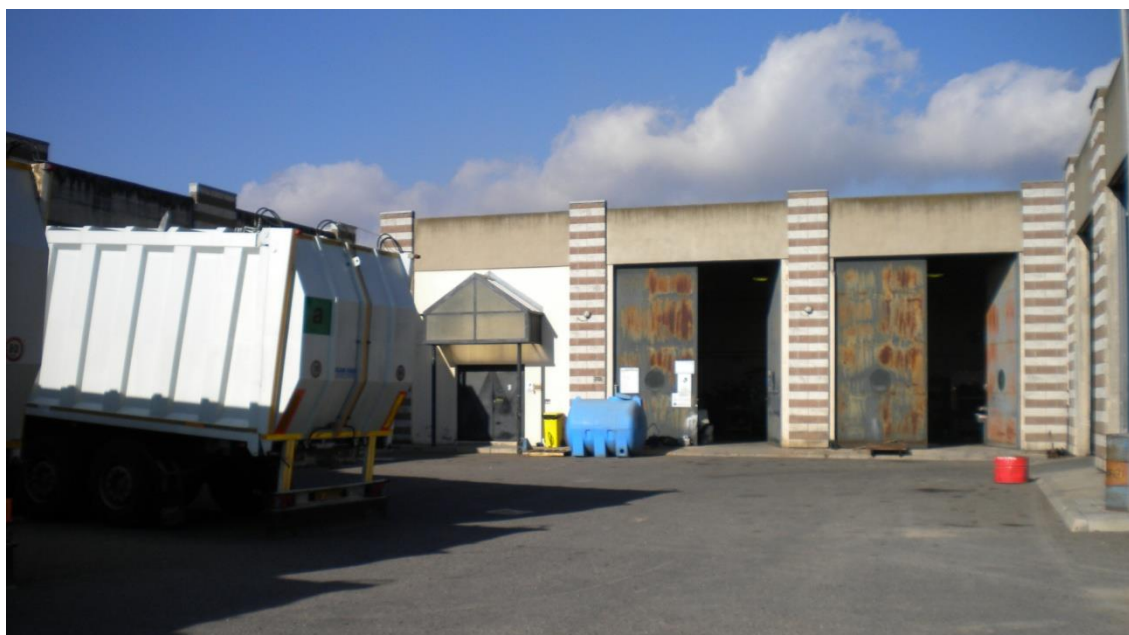
Figura 66 Edificio Officina – stato attuale
