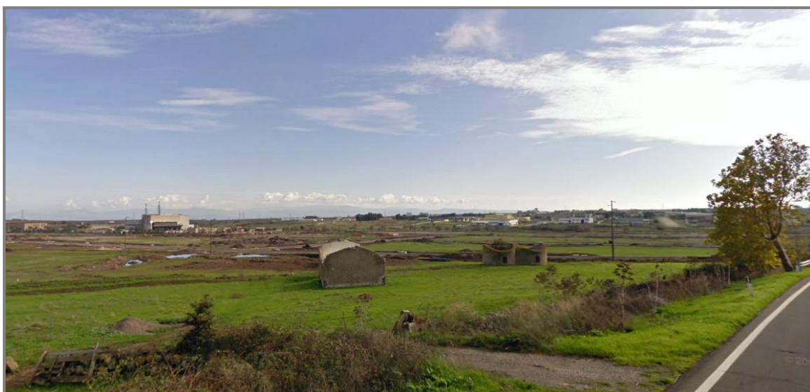
Figura 102 Vista panoramica verso l'agglomerato industriale di Tossilo (a sinistra è visibile il termovalorizzatore oggetto di intervento).
