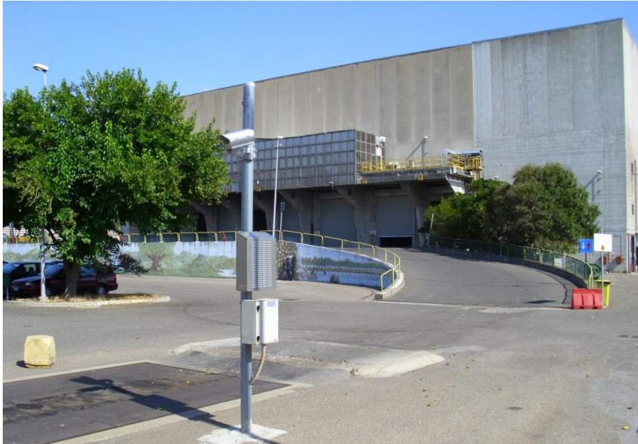
Figura 76 Area di ingresso all'attuale Edificio Fossa con il piazzale per il conferimento
