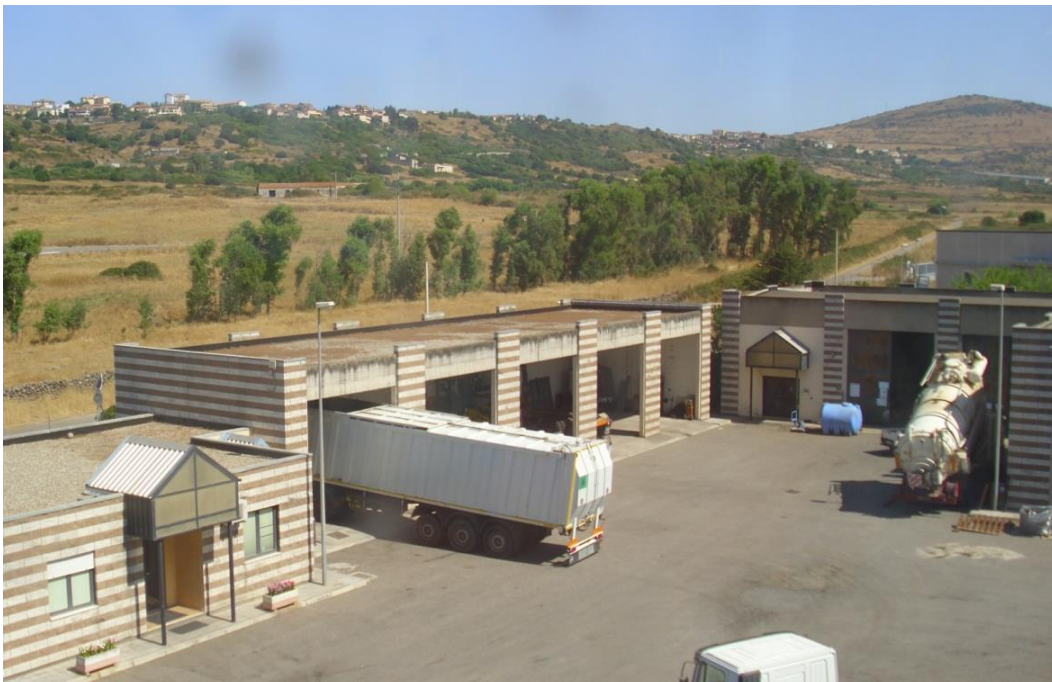
Figura 62 Edificio Autorimessa – stato attuale
