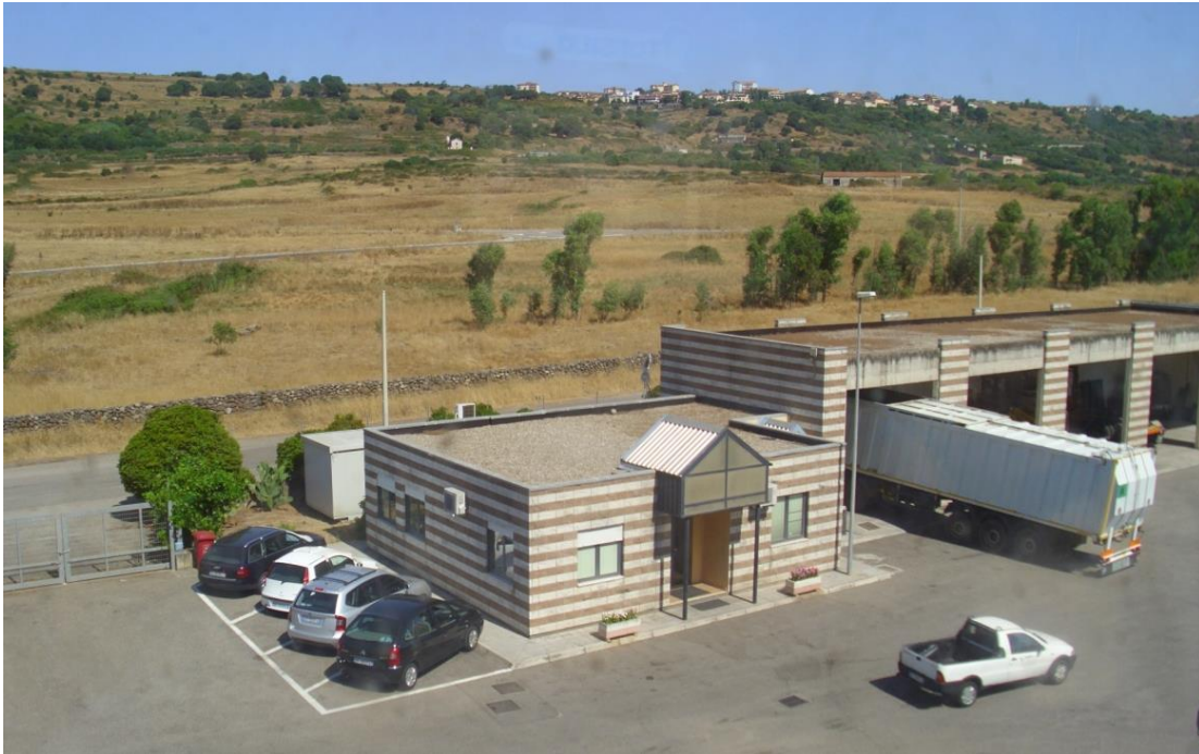
Figura 60 Vista dell'Edificio Servizi e dell'Autorimessa- stato attuale
