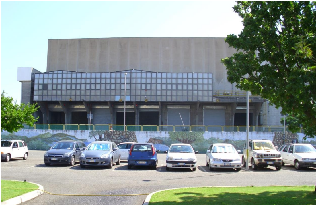
Figura 70 Edificio Fossa – stato attuale
