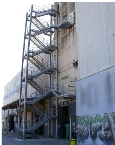
Figura 73 La scala esterna in acciaio da smontare e rimontare
