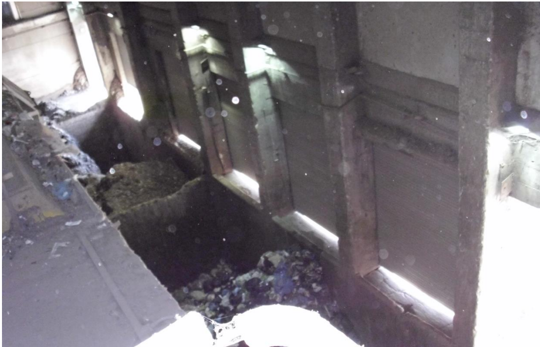
Figura 71 Edificio Fossa: la vasca di raccolta dei rifiuti – stato attuale
