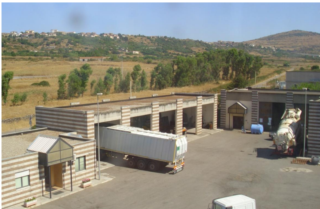
Figura 18 Edificio Autorimessa – stato attuale
