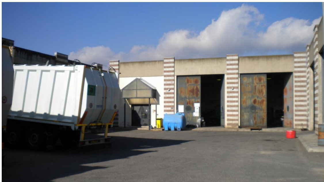
Figura 22 Edificio Officina – stato attuale
