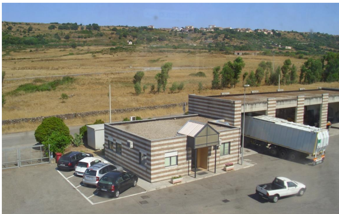
Figura 16 Vista dell'Edificio Servizi e dell'Autorimessa- stato attuale
