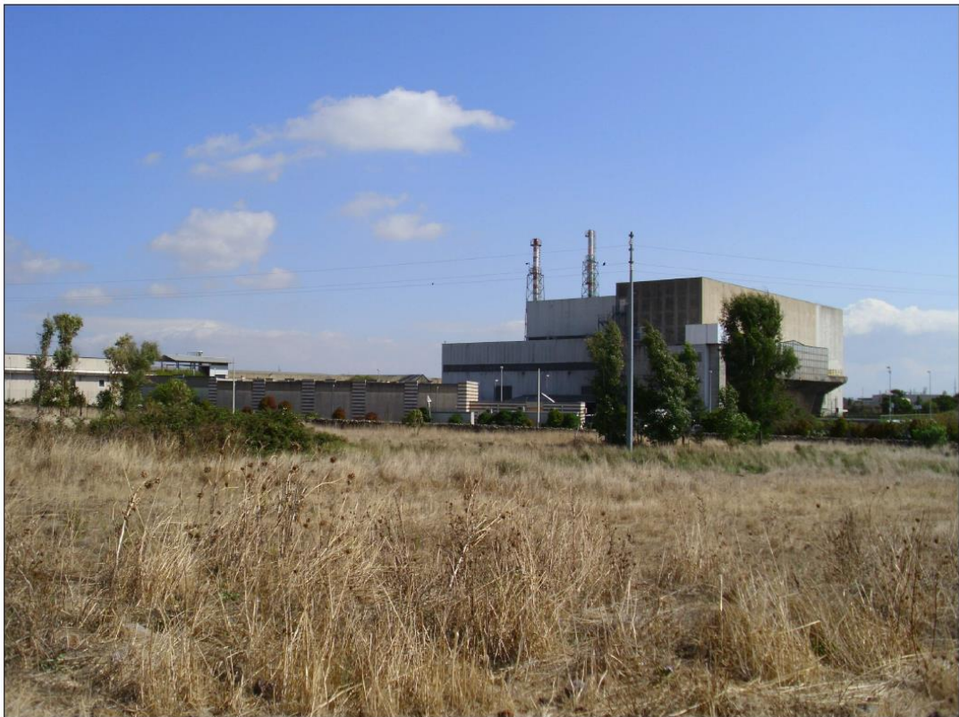
Scatto Fotografico di dettaglio 04 - Attuale
