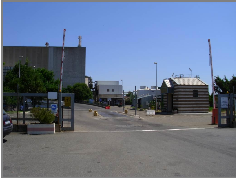
Figura 49 Foto 1a Area di ingresso all'impianto esistente
