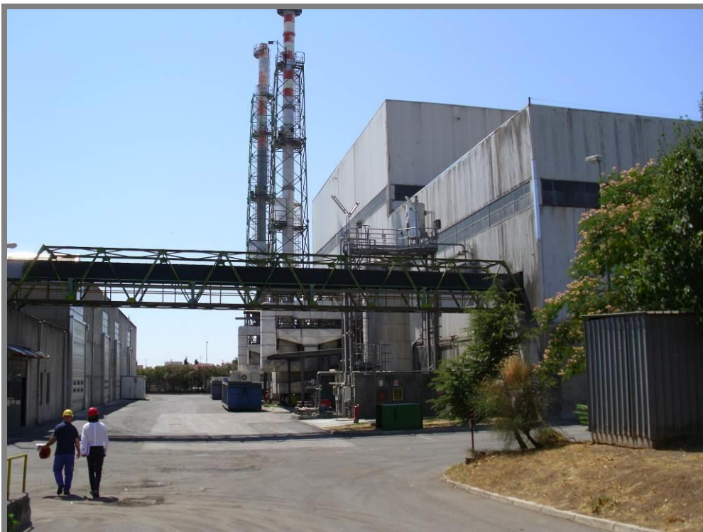
Figura 54 Foto 6a Vista dalla viabilità interna con a destra l'Edificio preselezione RSU ed il blocco della Linea di incenerimento con i camini.
