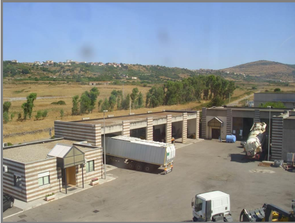
Figura 51 Foto 3a Vista dall'alto con da sinistra, gli edifici: servizi, autorimessa e officina e piazzale antistante
