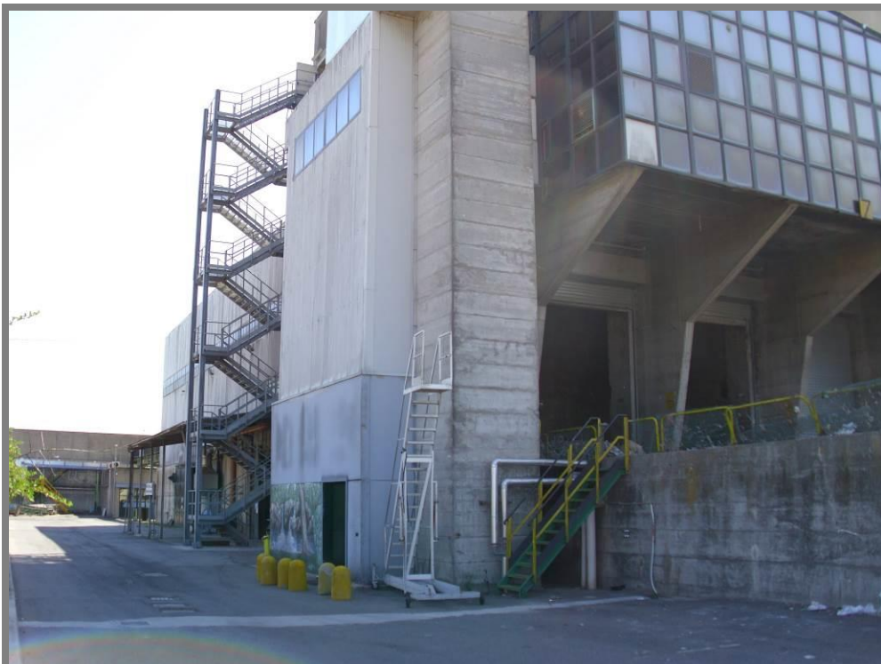
Figura 52 Foto 4a Vista dalla viabilità interna - lato sinistro Edificio Fossa
