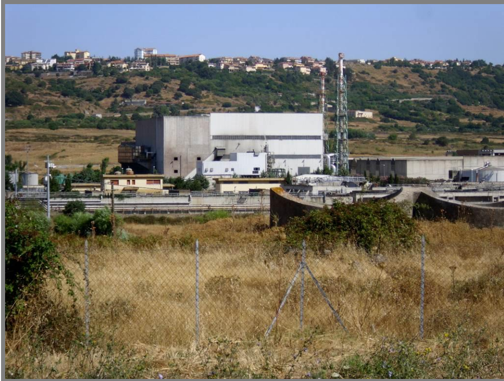
Figura 47 Vista dell'Impianto esistente con lo sfondo l'abitato di Macomer
