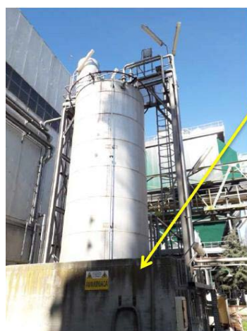
Vasca contenimento serbatoio
